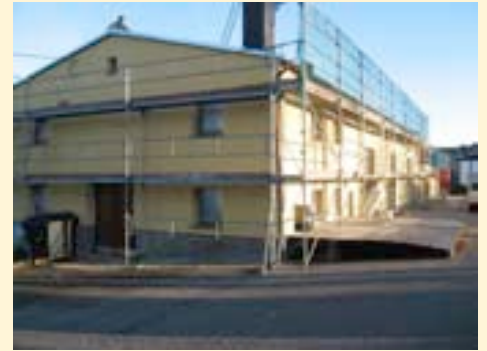
Die Turnhalle Arnsfeld wird zu einem Dorfgemeinschaftshaus ausgebaut
