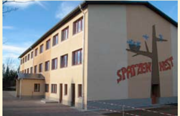
Die sanierte Kindertagesstätte „Spatzenest“
