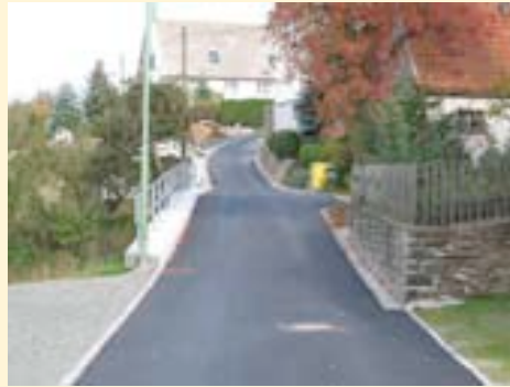
Die Zufahrtsstraße „Bergblick“ ist ausgebaut
